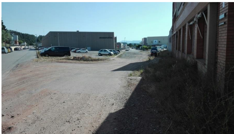
Tram del Carrer Manresa que s'arreglarà.
